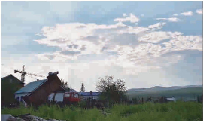
草原上,即使是一片建筑工地,也散发着浓浓的自然气息
