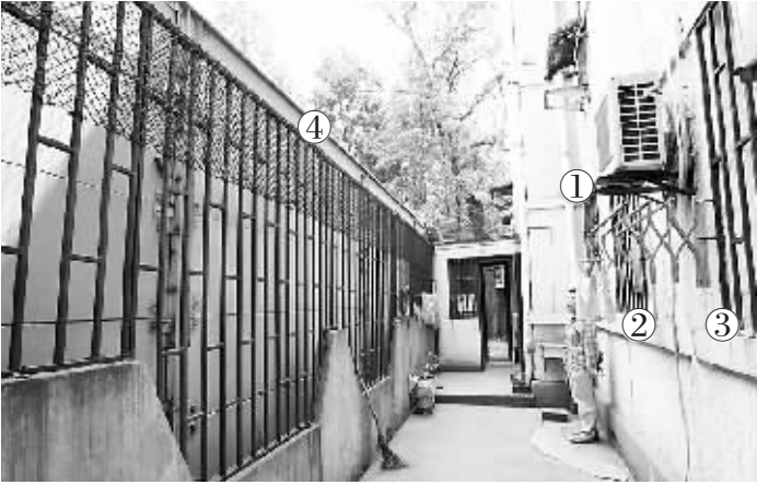
▲①②③处, 为蔡家的北窗; ④处为铁栅栏后砌起的3.3米高的实心围墙
