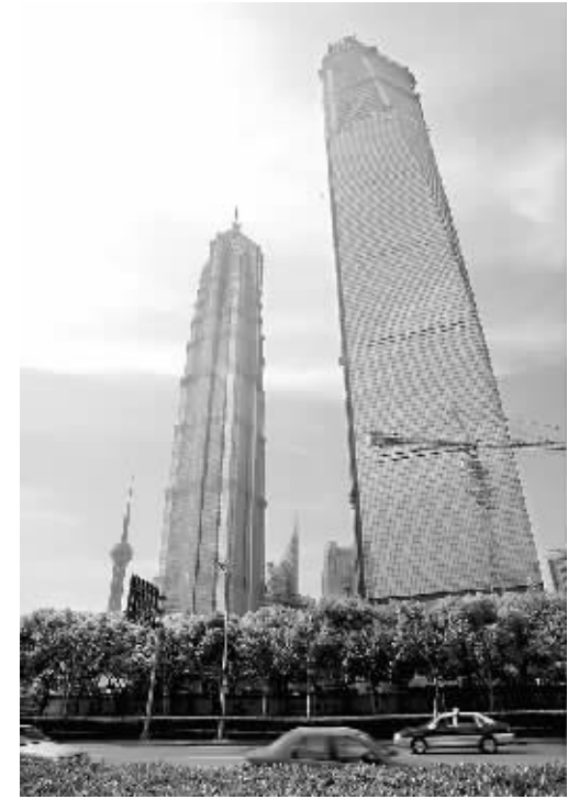
上海环球金融中心昨日顺利攀上 400 米。上海环球金融中心项目已施工至 91 层,高度达 398.93 米,桁架柱头最高标高达 400.2 米,已经超过了金茂大厦观光厅的高度。这项工程计划于今年 9 月达到 492 米的高度,实现结构封顶。 昨天,上海环球金融中心大厦已“长”至与金茂大厦等高,不久后将超过金茂大厦 本报记者 纪海鹰 摄影报道
