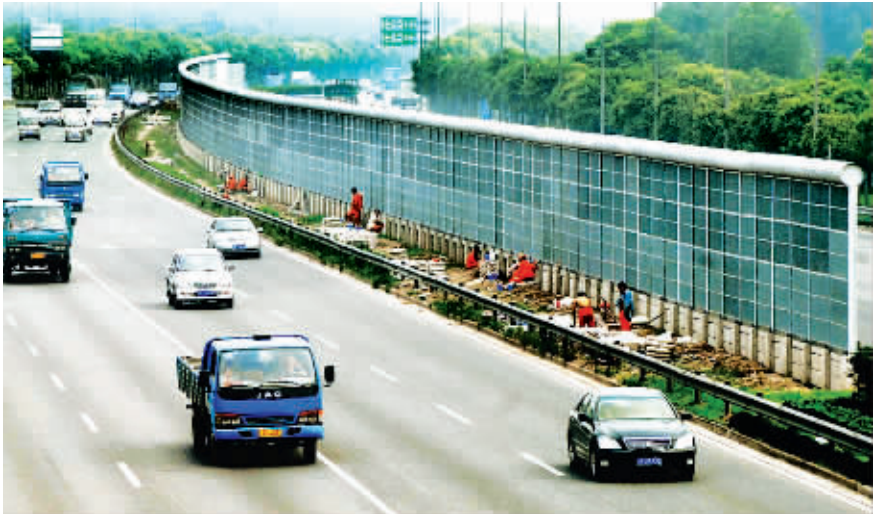
■ 工人们在外环线天山路段安装高近 7 米的防噪屏
