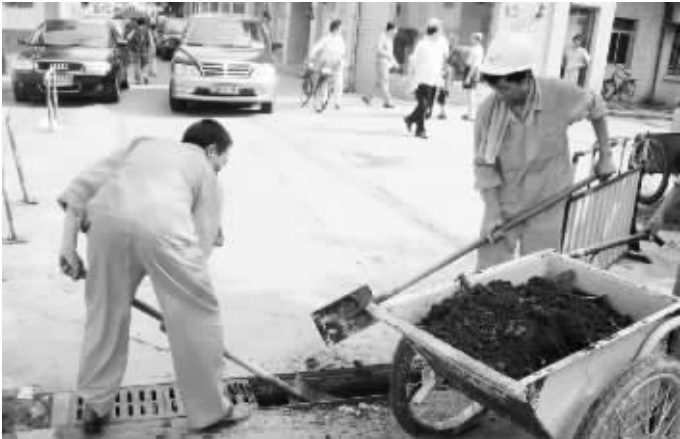
施工人员上午开始修复一处雨水篦子
