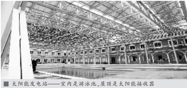
■ 太阳能发电站——室内是游泳池，屋顶是太阳能接收器
