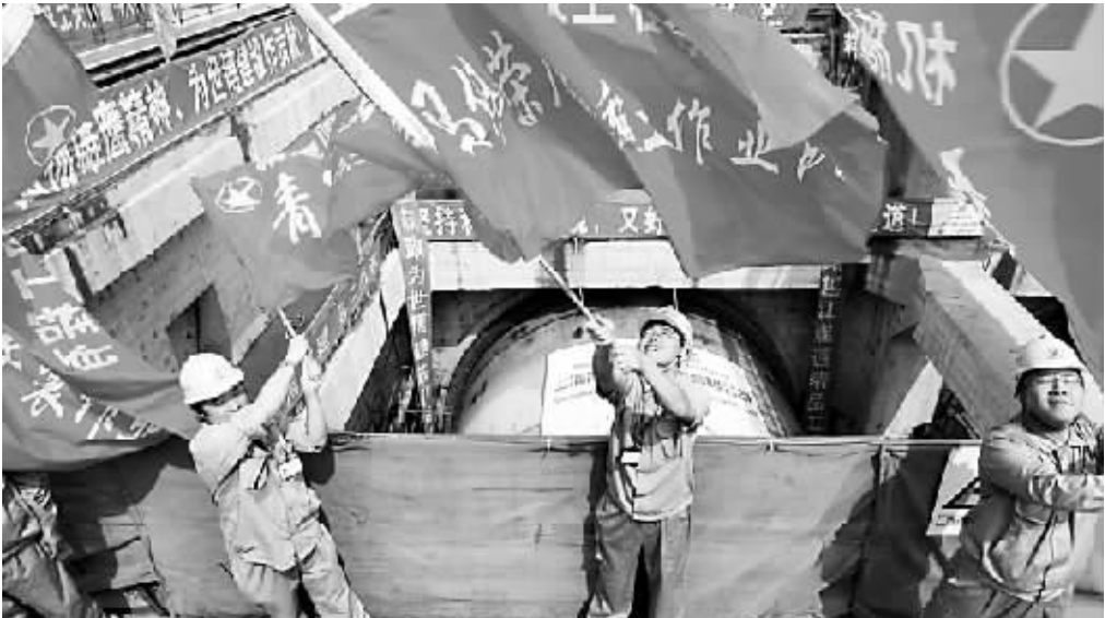
■西藏南路越江隧道工程西线盾构上午9时30分开始向浦西方向掘进
