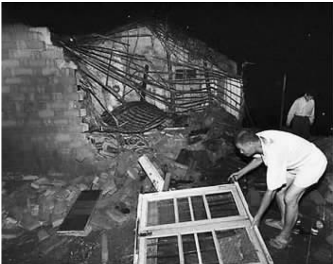
■ 建华村村民在清理被风刮倒的房屋
