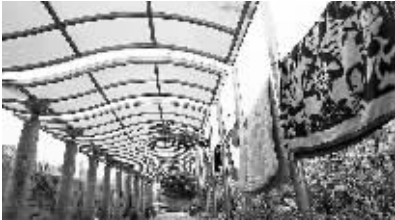
■ 休闲长廊多处狗屎人粪,臭味刺鼻。铁架子晒着被晾衣裳
