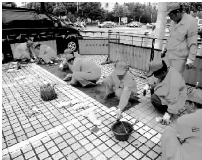
■工人们正在修补闵行报春路水清路口的一段人行道 本报记者 张龙 摄
