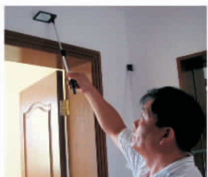
■用特殊的“拐角镜”检测门框顶端隐蔽处
