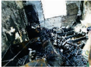
■ 图为火灾现场
