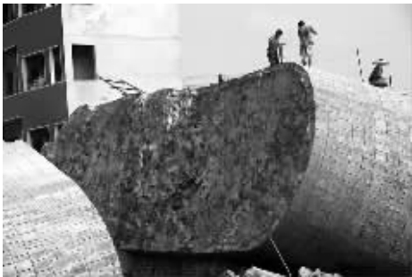
■ 工人将倒塌的桥墩进行解体
