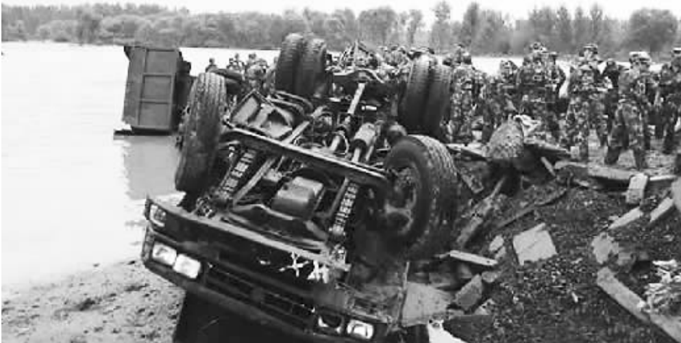
■ 抢险人员在封堵导致煤矿溃水事故的缺口
