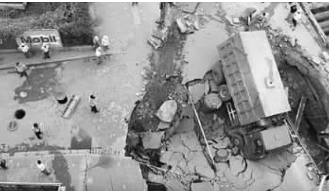
南京马路塌陷,1辆重达13吨的工程车陷入坑中
