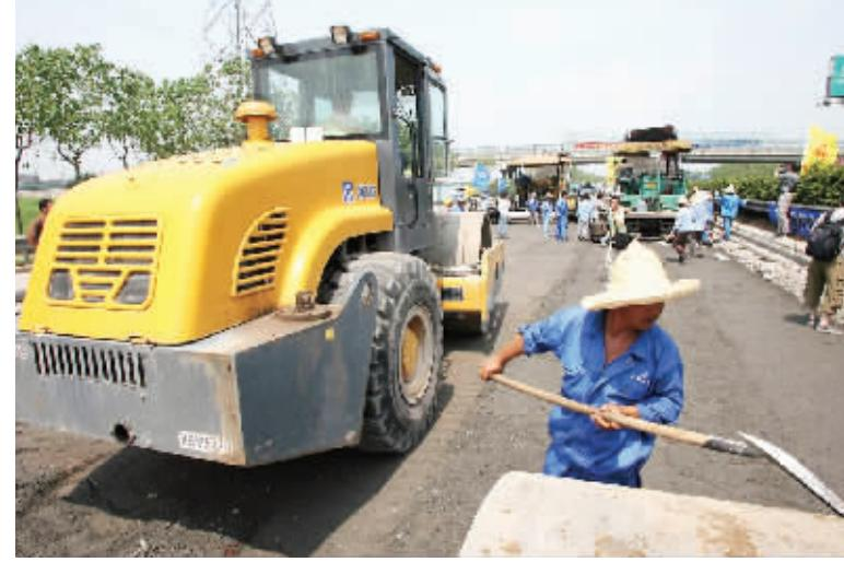
旧沥青经过破碎、加工、碾压等一系列程序后,就能“变身”为路面新基层。在嘉浏高速公路整治一期工程中,市政一公司建设者采用了全新的再生技术。经过检测,这种路面新基层的各项技术指标,均符合设计要求,比起传统的石灰、粉煤灰、泥土混合料,抗压强度提高了近2倍,使路面使用寿命得到了一定的延长。
