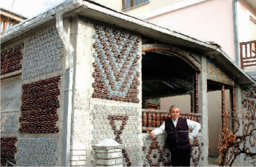
■拉多万诺维奇在用塑料瓶建造的房屋前留影
