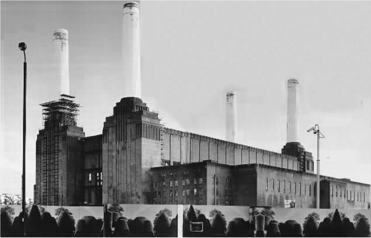
■ 远看像一张倒立“巨形方桌”的伦敦地标建筑——巴特西发电站
