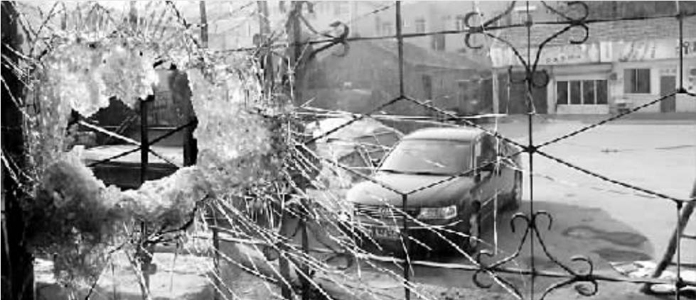
昨天7时30分许,山东省滨州市一农业银行储蓄所发生爆炸,造成室内管道及窗户破
