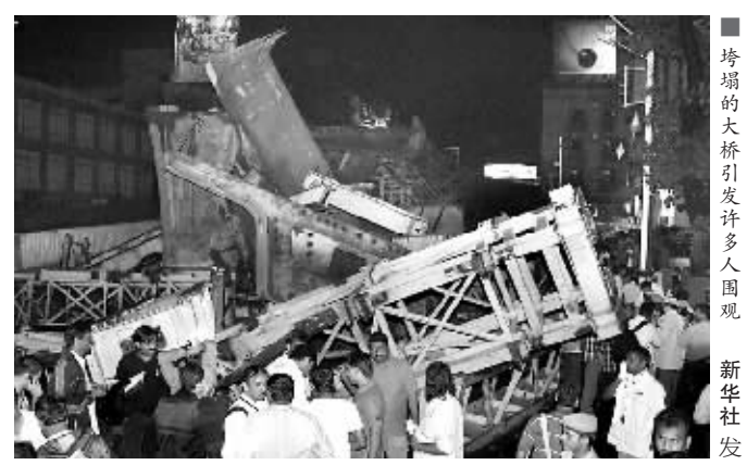
■垮塌的大桥引发许多人围观 新华社发 致死亡数字上升。 印度总理曼莫汉·辛格发表声明说:“我为这一事件震惊并感到深深的悲痛。” CNN-IBN 电视台报道说,出事高架桥已建设一年多,原本计划今年 12 月通车,垮塌的主要原因可能是建筑质量不好,无法抵御暴雨侵袭。
