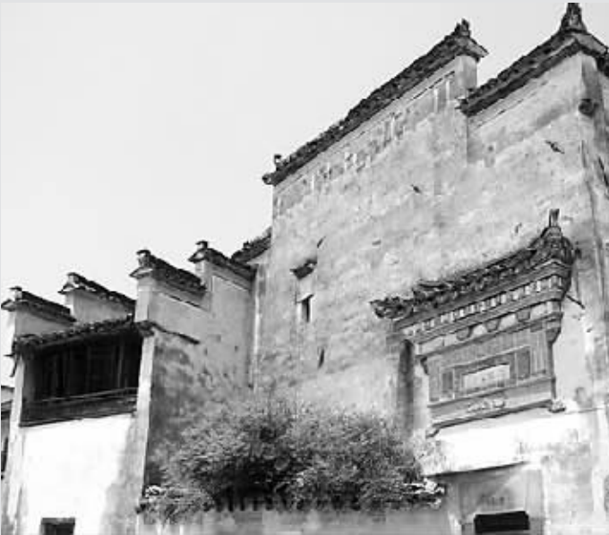
■ 屏山古村老建筑外景
