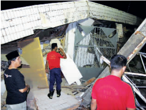
居民和消防队员察看震塌的房屋
