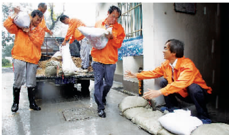
▲ 10时30分 杨浦区卫百辛集团延吉急修中心抢险队员在低洼居民楼前堆放防水沙袋
