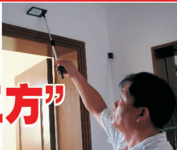
■用特殊的“拐角镜”检测门框顶端隐患处
