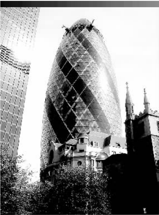
▲ 采用斜交叉网格结构的高层建筑英国“伦敦巨蛋”
