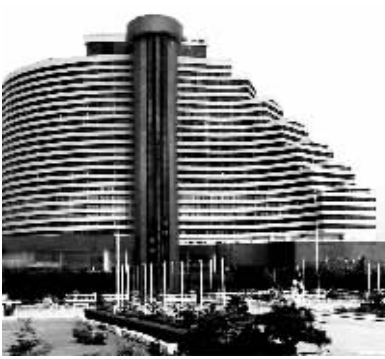
▲ 上海最早采用圆弧剪力墙结构的高层建筑华亭宾馆
