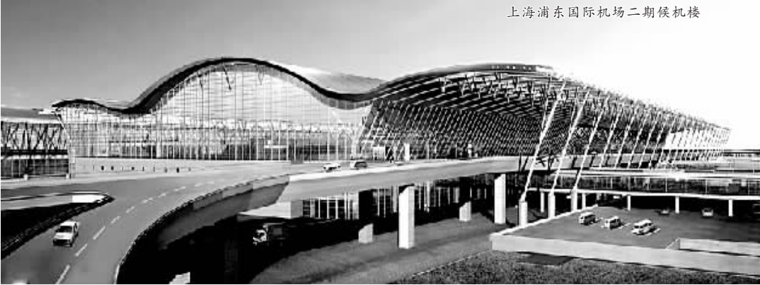
▼ 采用了大跨度连续张弦梁结构的上海浦东国际机场二期候机楼
