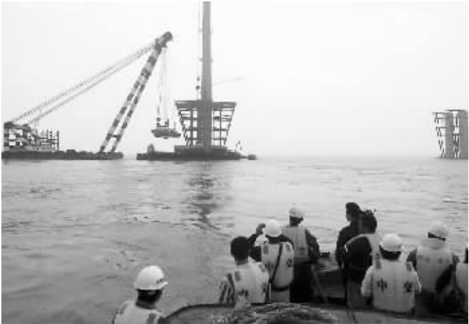
■ 今天上午9时30分,主桥首节桥面钢箱梁开始吊装 首席记者 雍和 摄
