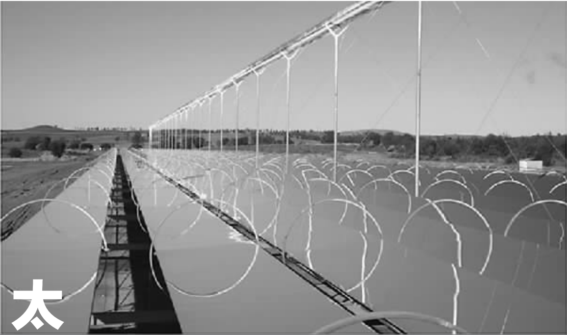
■ 太阳能热发电实验基地
