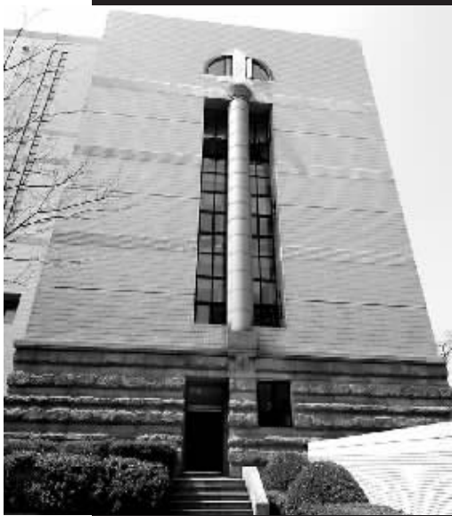
■裙房阅览室的宽幅竖条窗和半圆收头窗，以虚托实，强化了壁柱的形象
