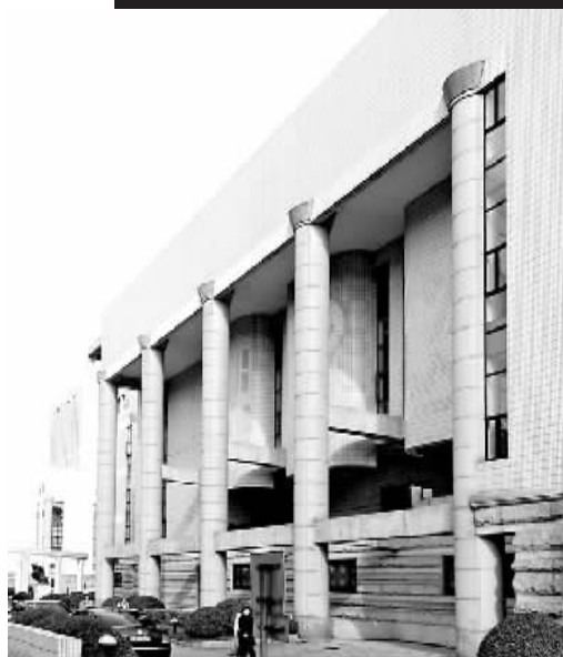
■光线的变化使同色异形面砖表现出“日、月、山、川”的象形文字图案
