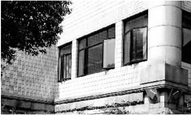
■裙房外墙的毛石装饰和阅览室的宽幅竖条窗
