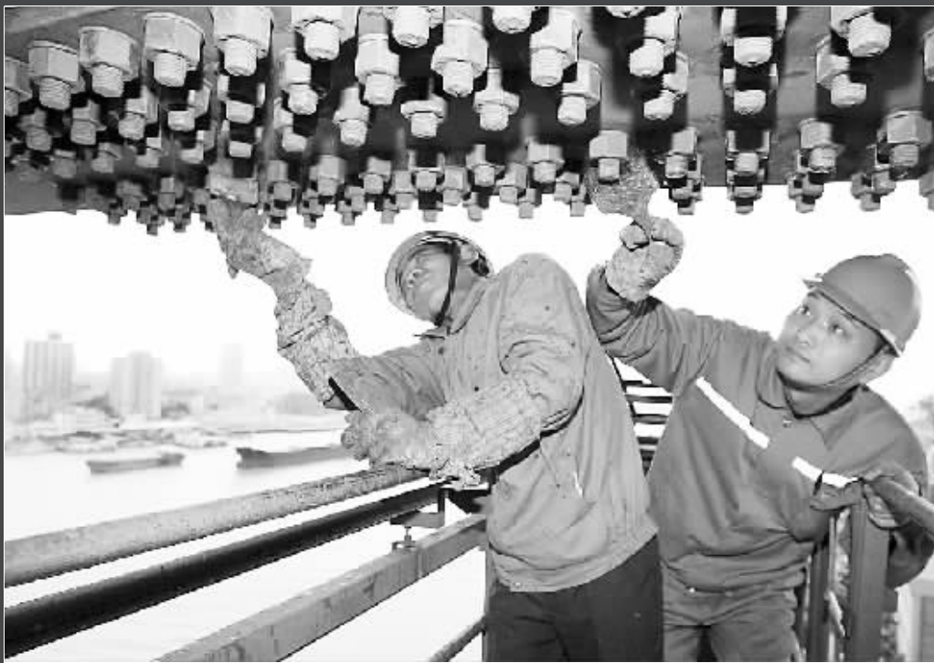
■ 工人在养护南浦大桥的桥底钢梁
