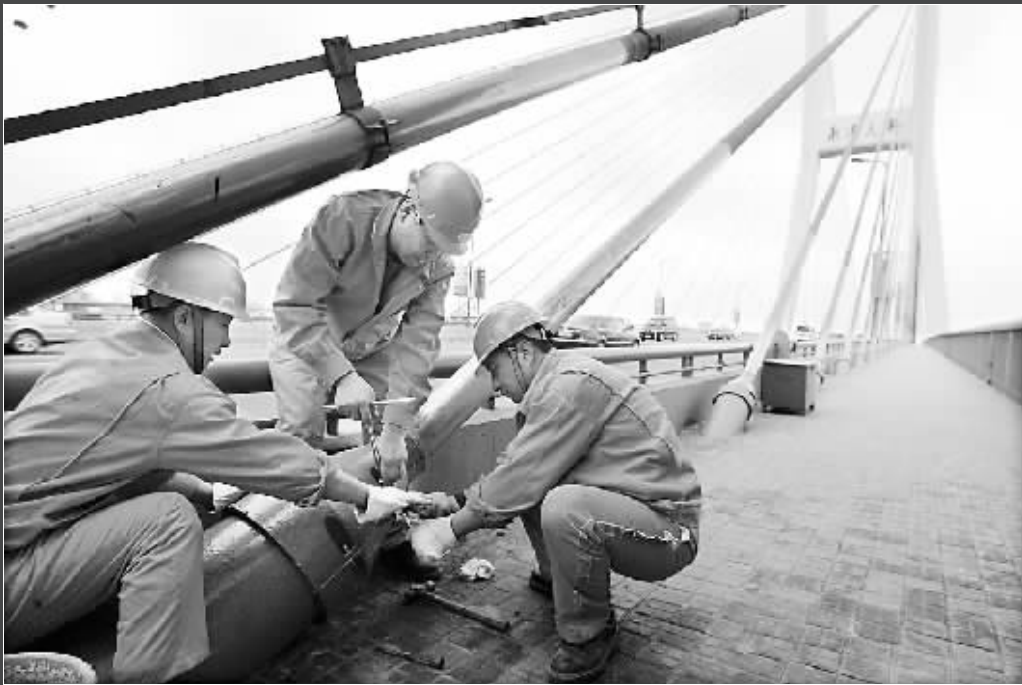
■ 昨天下午,工人在养护南浦大桥的斜拉索钢锚
