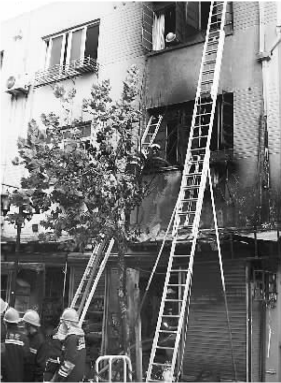
■ 一楼香烛店失火，波及到二楼三楼
