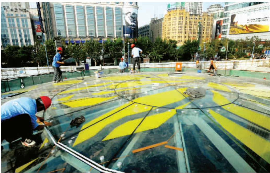
施工人员正在给换乘大厅的“采光天窗”安装透光玻璃
