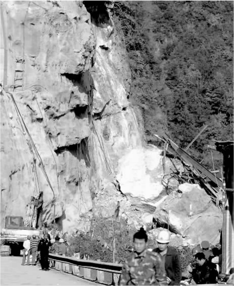
■ 岩崩滑坡事故后的宜万铁路高阳寨隧道隧道口 新华社记者 郝同前 摄
