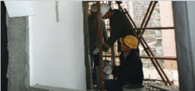
打造生态住宅——外墙面添加保温材料。
