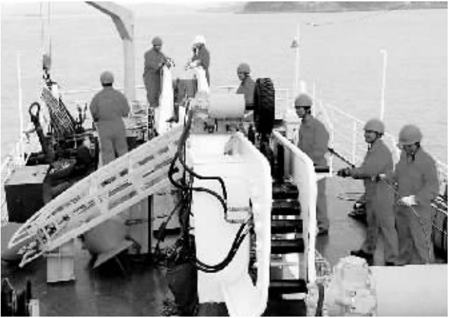
■ 在茫茫大海上,中国电信上海公司的海缆施工人员将海缆铺向远方
