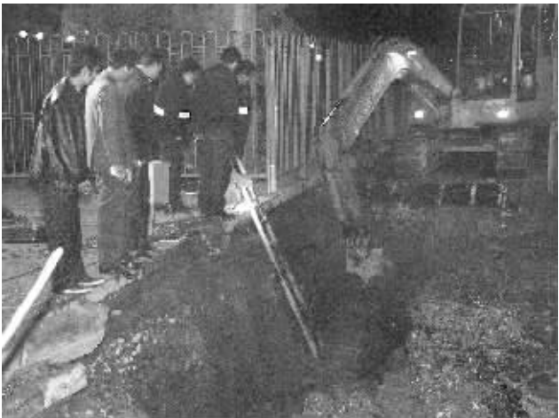
燃气公司有关人员正在现场抢修
