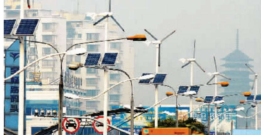
一种新型的风力太阳能路灯近日出现在宝杨支路150米长的沿江道路上，这种路灯的上部是一架发电的风车，中间是两块太阳能电池板，将风能和太阳能转换成电能储存在蓄电箱内，在晚间发光照亮路面。
