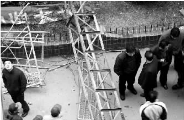
■ 倒塌的通信塔架
