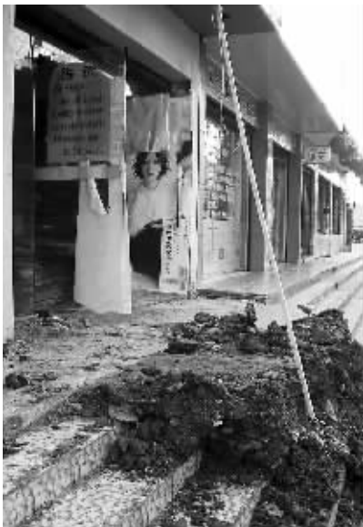
■ 店铺门口堆放着挖出的泥土 子歌 摄
