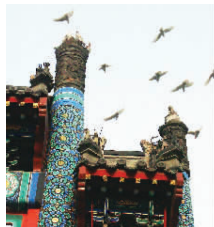
北京老胡同的牌坊修缮一新 本版图片 TP
