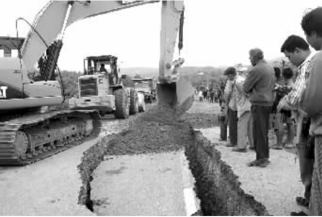
■ 3 月 27 日，人们在抢修一条被地震损坏的公路
