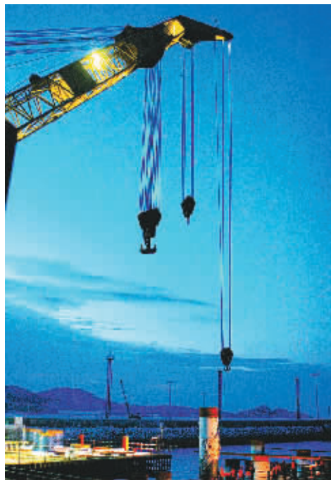
■ 洋山深水港夜间施工
