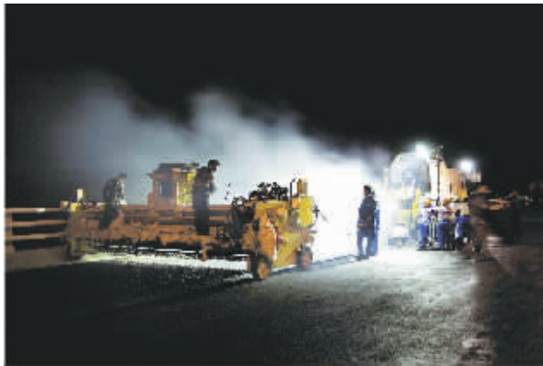
■ 长江隧桥摊铺沥青
