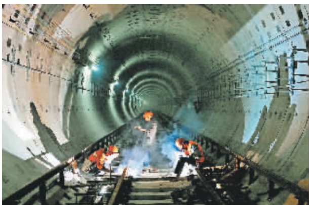
■ 建设上海轨道交通一丝不苟,安全第一
