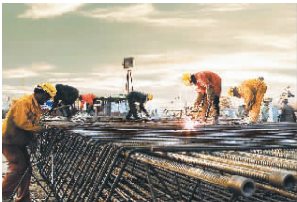
■ 虹桥综合交通枢纽焊接施工
