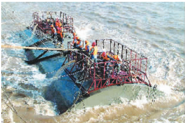
■ 长江口深水航道工程建设者不畏艰险,在深水中作业
