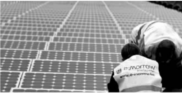
■ 工人在隧道顶部铺设太阳能电池板
