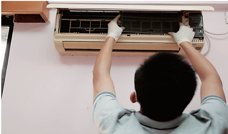
■取下过滤网,露出散热片
