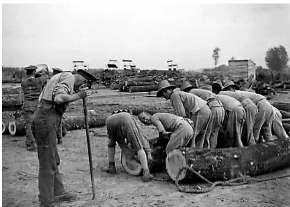
▲华工主要从事修铁路、挖战壕、搬运物资等工作
