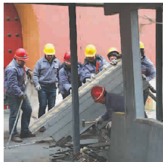
▲钟表馆检票房的彩钢房昨日拆除
