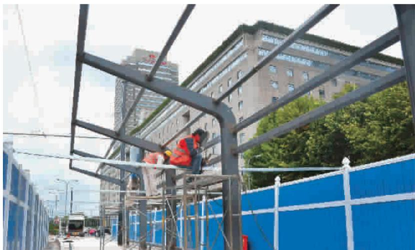
线路总长为17.5公里,备受广大市民关注的延安路中运量公交系统工程眼下已经进入施工高峰期。沿线各个车站都在紧锣密鼓地施工。据悉,延安路中运量工程力争今年基本完工,明年初实现试运行。图为施工人员在娄山关路站焊接车站候车棚
