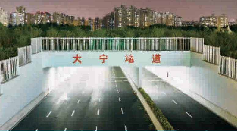
大宁地道基本完工 近日,连接万荣路与大宁路的大宁地道已基本完工。地道穿越大宁郁金香公园,设双向四车道,并在广中西路出入口处变为双向7车道。地道通车后能在一定程度上缓解南北高架拥堵情况。 本报记者 陈梦泽 摄影报道
