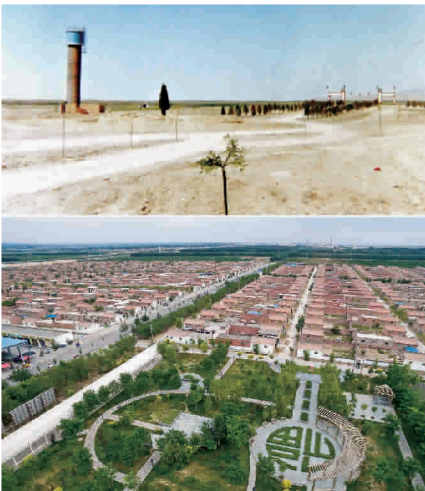
■ 上图为宁夏永宁县闽宁镇建设初期的乡镇雏形(资料照片);下图为2016年7月22日拍摄的闽宁镇原隆移民村。地处宁夏贺兰山东麓的闽宁镇,是福建、宁夏两省区对口帮扶打造的样板镇 新华社发
