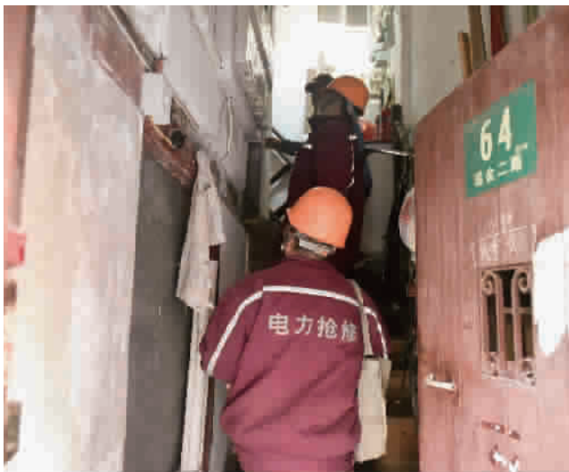
▲ 上午电力抢修人员赶到瑞金二路报修点为市民检修电路
