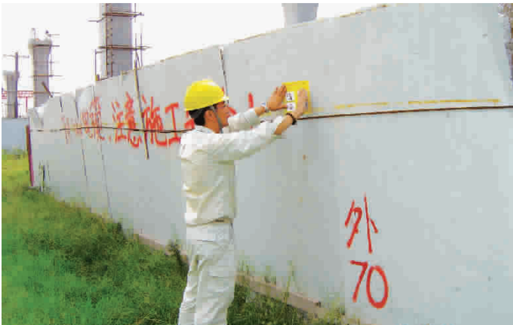
■ 供电部门在施工现场外张贴护线标识
